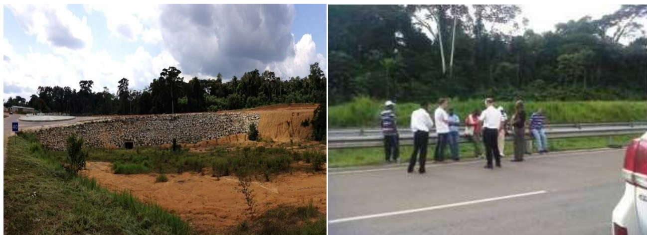
Figura 29. Visitas del equipo del PANA durante la misión de evaluación de la vulnerabilidad en la Región Continental de Guinea Ecuatorial durante el proceso del PANA. A la izquierda se muestra una obra de protección a la carretera a la entrada de Mongomo, y a la derecha el equipo PANA intercambia sobre los posibles impactos ambientales la zona en Oyala (Wele Nzas) (Fuente: Braby 2013, el proceso de elaboración del PANA).
