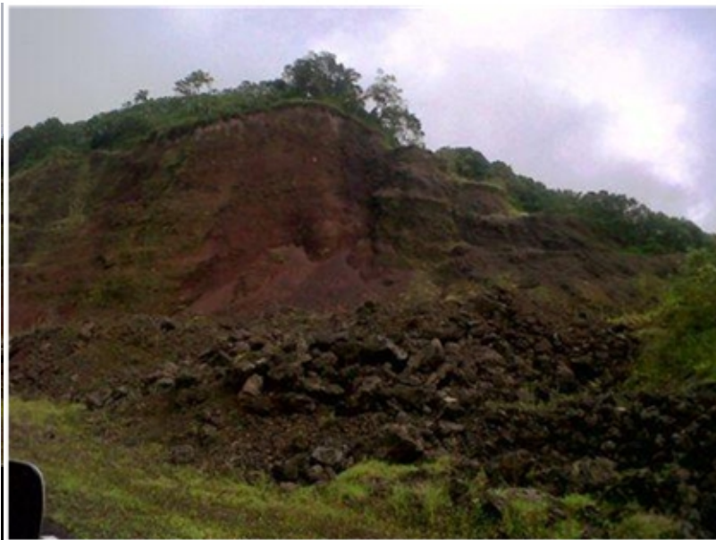
Figura 22. Extracción de grava y arena para la construcción de carreteras que aumenta la vulnerabilidad de las carreteras expuestas a derrumbamientos de tierra. Fuente: Braby 2013, miembro equipo PANA.
